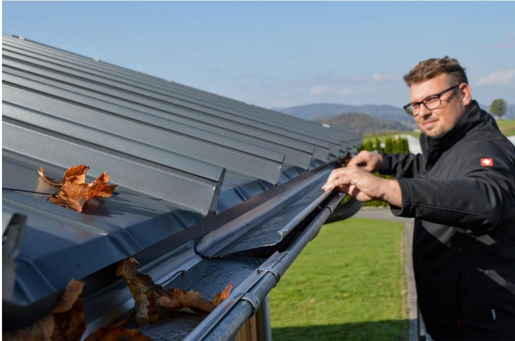
*Die Montage erfolgt werkzeuglos: Das Gitter wird mithilfe der Stützbügel in die Rinne eingelegt und an der Wulst fixiert. Das integrierte Überlaufstopband gleicht Maßunterschiede aus und verhindert ein Übertreten des Wassers. Foto: Zambelli Holding GmbH*
