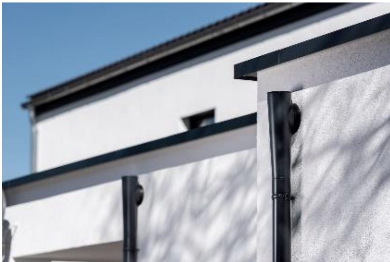
Der Attika-Stutzen wird nach dem einfachen Formschluss-Prinzip angeschlossen. Ein Lippendichtring gewährleistet die Dichtheit zwischen Attikarohr und Stutzen. Foto: Zambelli Fertigungs GmbH & Co. KG
