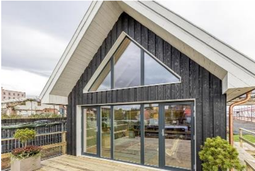
Die Initiatoren von „Beyond Zero Homes“ zeigen mit dem „COP26-House“ einen nachhaltigen Bau der Zukunft. Foto: © Fourfifteen
