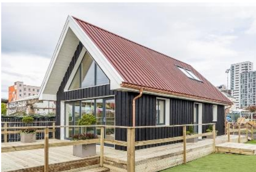
Für das „COP26-House“ kamen nur Baustoffe zum Einsatz, die wiederverwertbar sind und einen geringen CO 2 -Ausstoß in der Herstellung vorweisen können. Foto: © Fourfifteen
