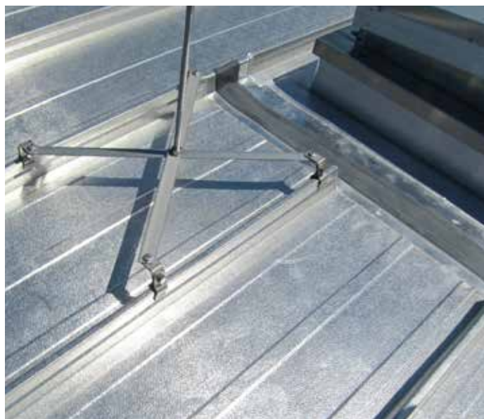
Navařený klenutý světlik s dilatačním pásem; konzole pro bleskosvod
