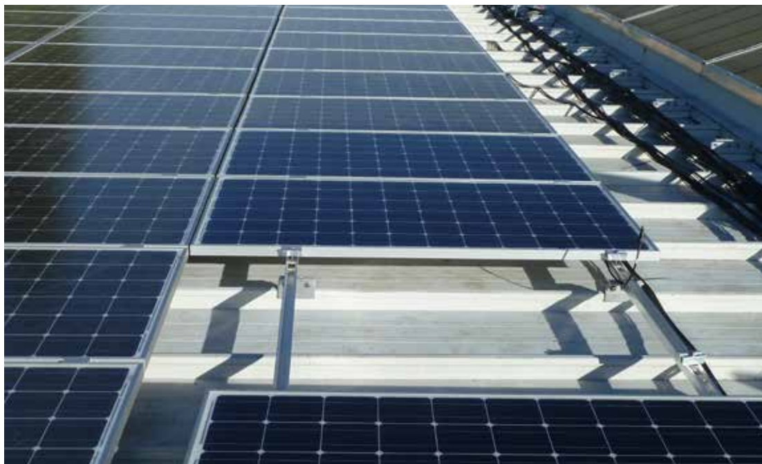
Instalace paralelně se střechou
