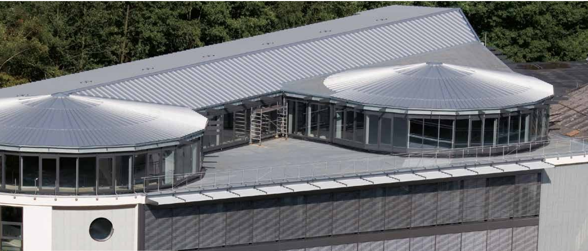
Betriebsgebäude Mennekes®, Kirchhundem
