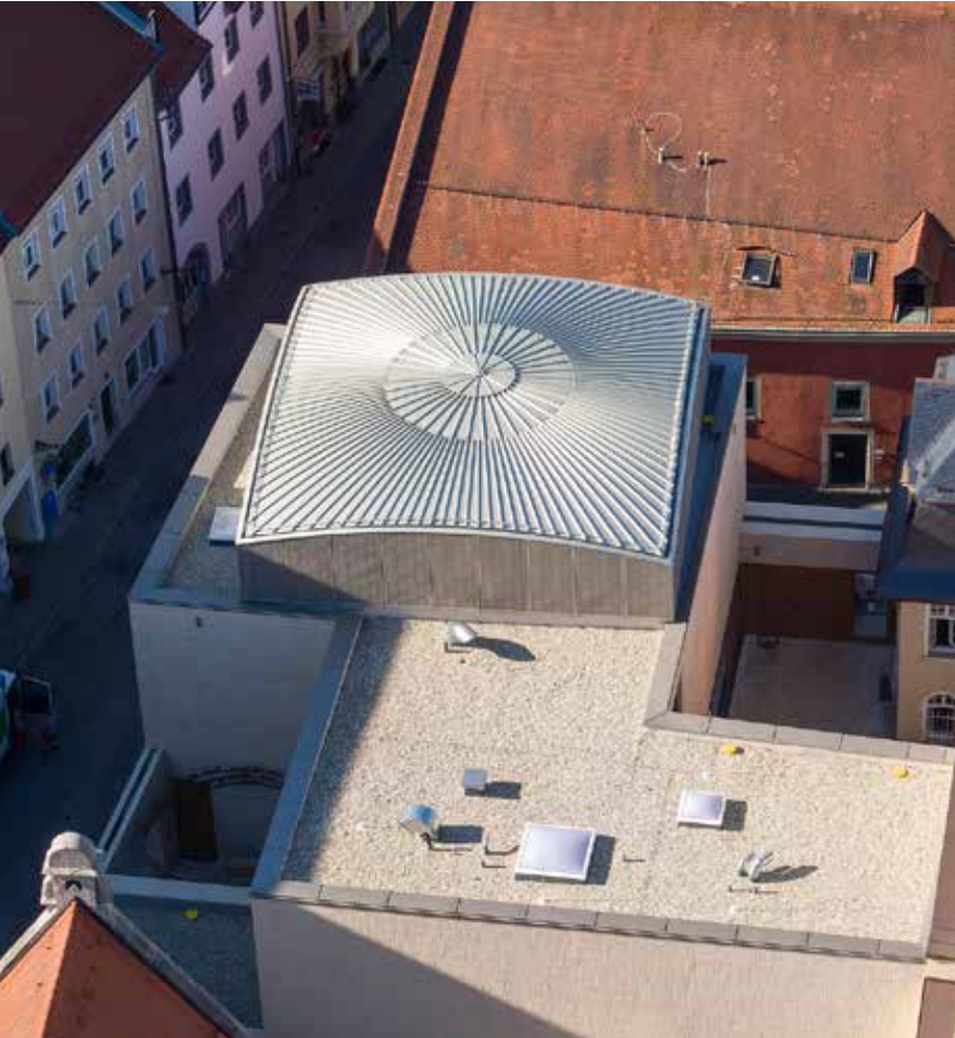
Neues Jüdisches Gemeindezentrum mit Synagoge, Regensburg
