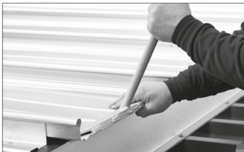
Aufstellen der Profilbahnen auf der Baustelle mit Aufstellwerkzeug
