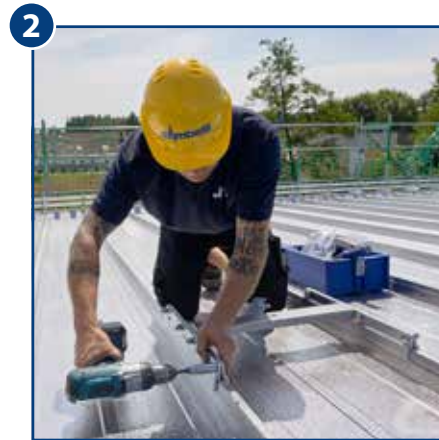
Anschlagpunkt am Profil einrasten und Schrauben leicht anziehen.
