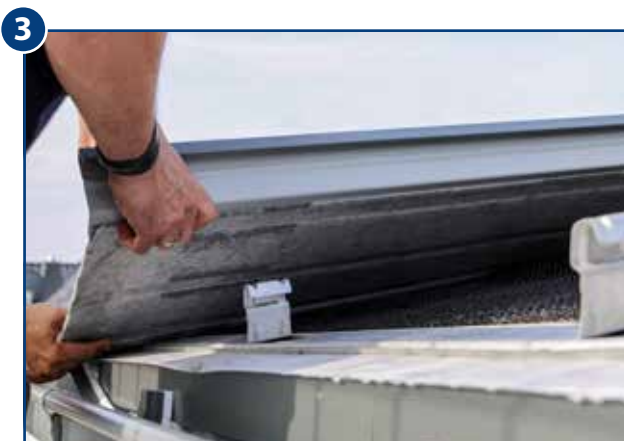
Einschwenken und Einrasten der RIB-ROOF Profilbahnen in die Cipleisten
