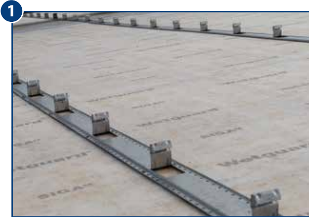
Vormontage mittels Cipleisten oder Standard-Clips auf einer mit Holzschalung und diffusionsoffener Schutzbahn vorgedeckten Dachfläche
