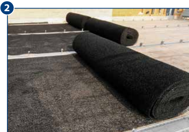
Ausrollen der strukturierten Trennlage als Zwischenlage
