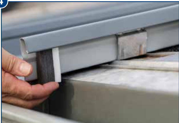
Traufausführung mit traufseitig montierten Profilfüllern und Traufwinkel
