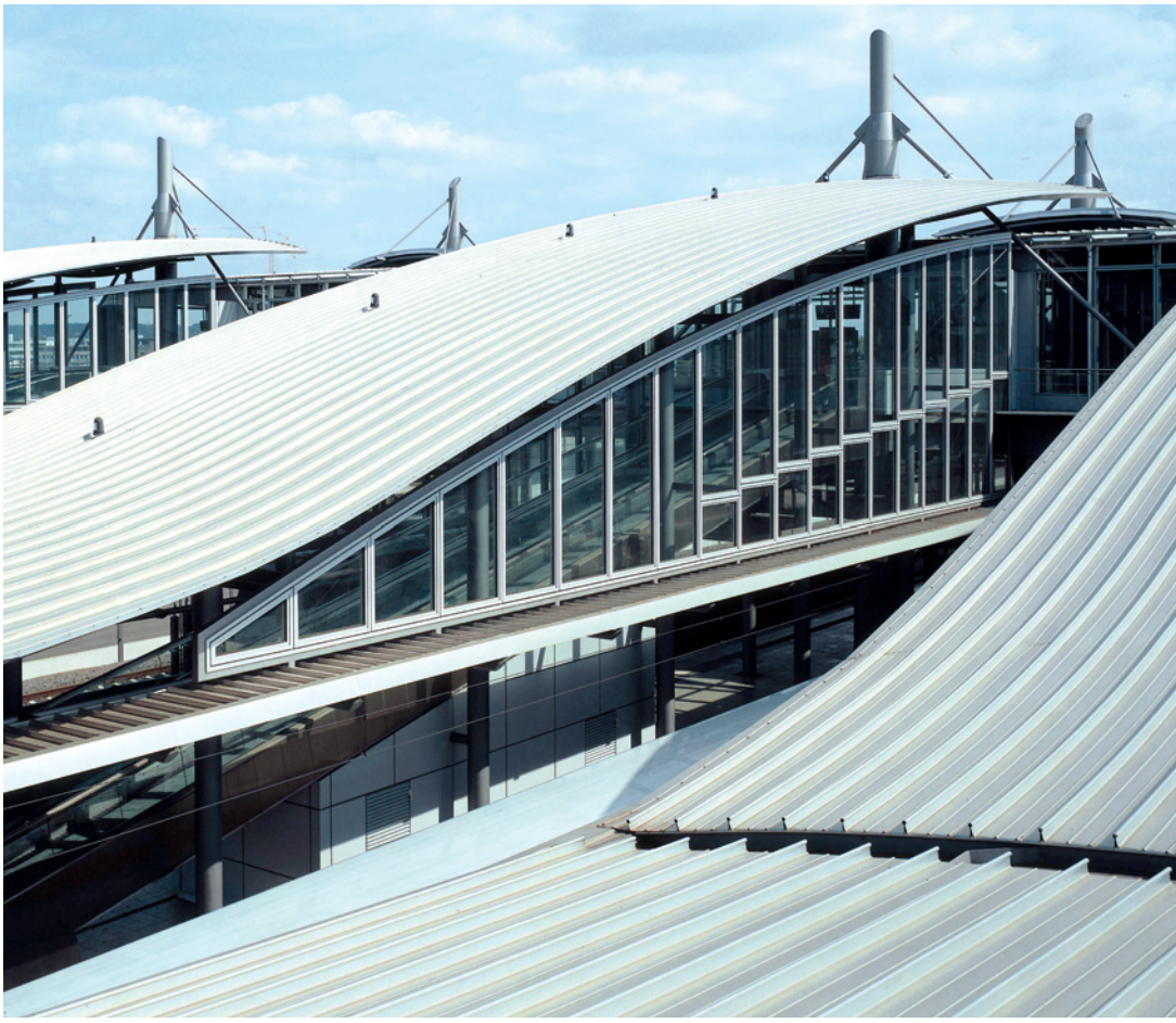
Flughafenbahnhof Düsseldorf Baujahr: 2002 Bauherr: Flughafen Düsseldorf GmbH
