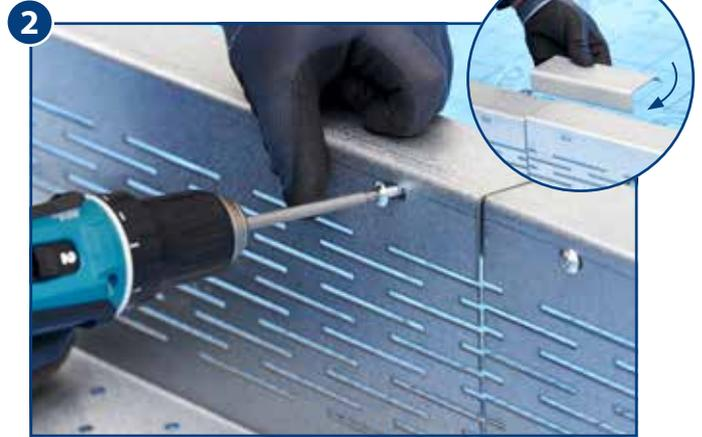
2 Stoßverbinder hinterlegen und beidseitig am Thermo-Z Distanzprofil befestigen. Ausdehnungsfuge von ca. 3 bis 5 mm einrichten.
