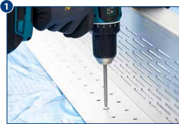
1 Thermo-Z Distanzprofil versetzt in jedem Trapezblech-Obergurt befestigen oder mit gleichen Abständen in andere Unterkonstruktionen.
