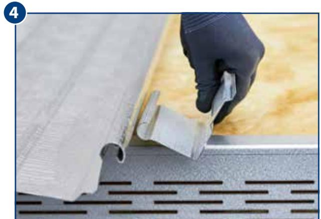
4 Die Verlegung der Profilbahnen auf Thermo-Z Distanzprofile kann ausschließlich mit Richtclips oder Richtprofile ausgeführt werden.
