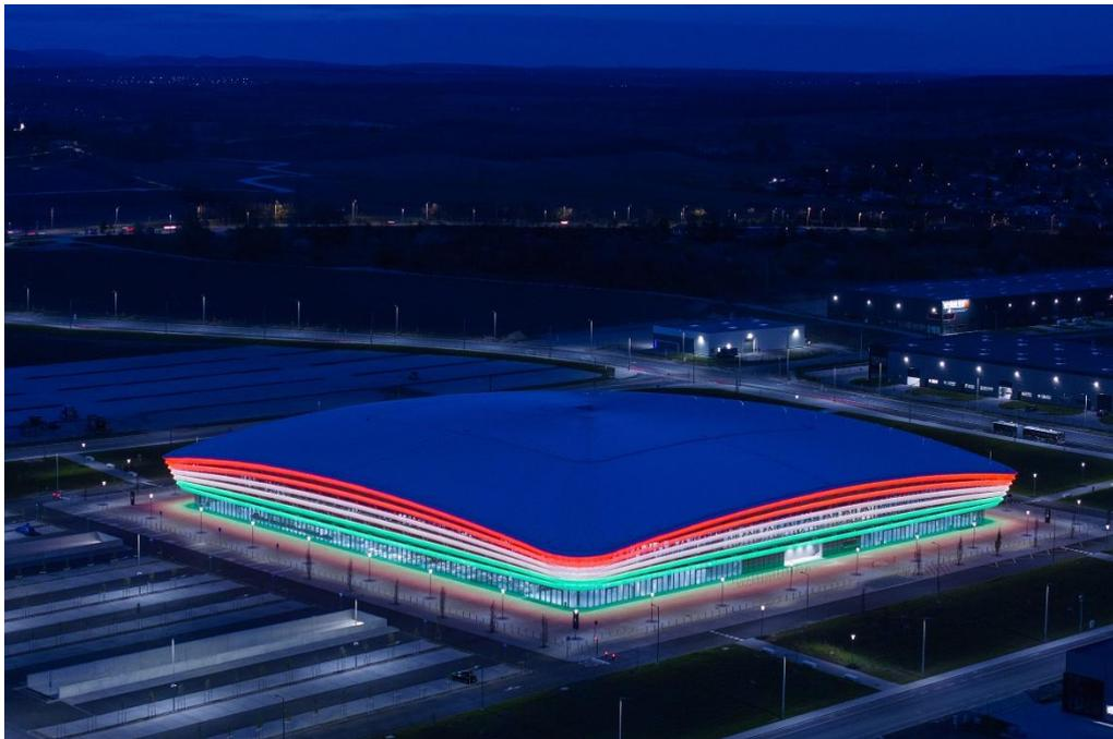
*Die Dachfläche besteht aus fünf Teil-Dachflächen, die eine gewölbte Gebäudeform nachzeichnen. Die konische Fertigung der Bahnen ermöglichte eine passgenaue Abdeckung.
