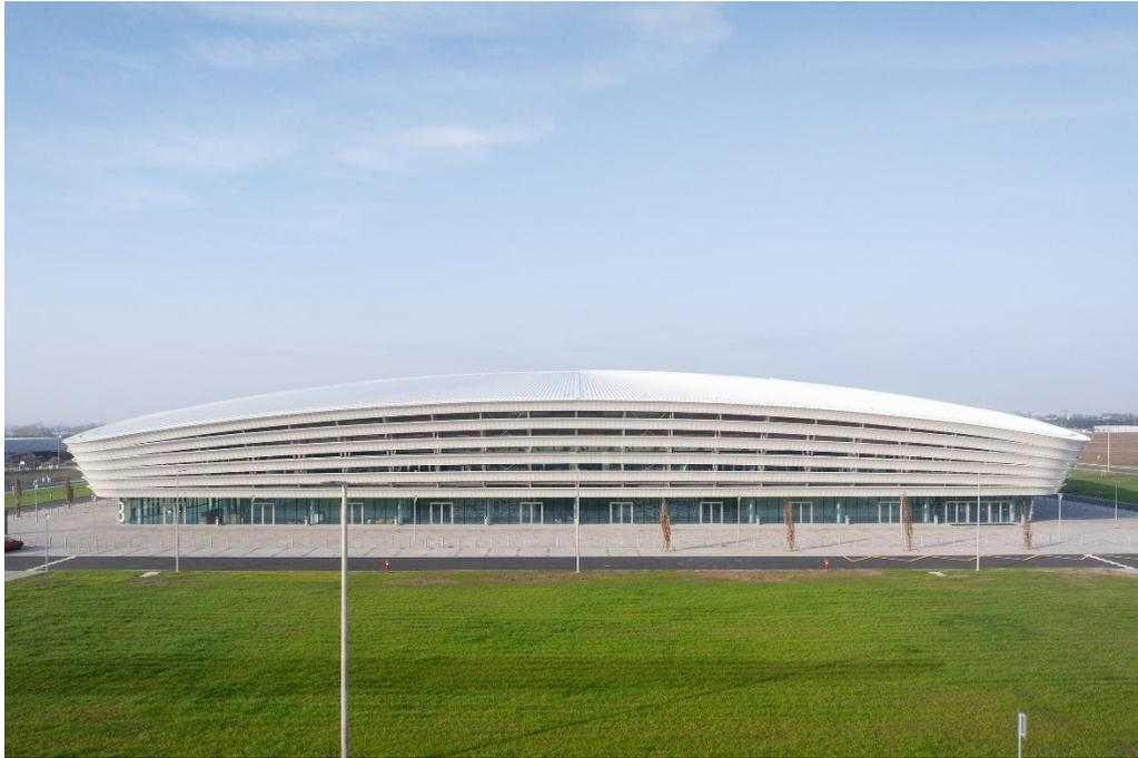
*Eine speziell ausgerichtete Unterkonstruktion gibt eine genaue homogen sphärische Oberfläche für die darauf liegenden Profilbahnen vor. Diese wurden aus 1,0 mm starkem Aluminium in Längen von bis zu fast 39 m vor Ort produziert. Eine temperaturbedingte Längenausdehnung der Profilbahnen wurde mit eingeplant. Foto: György Palkó*
