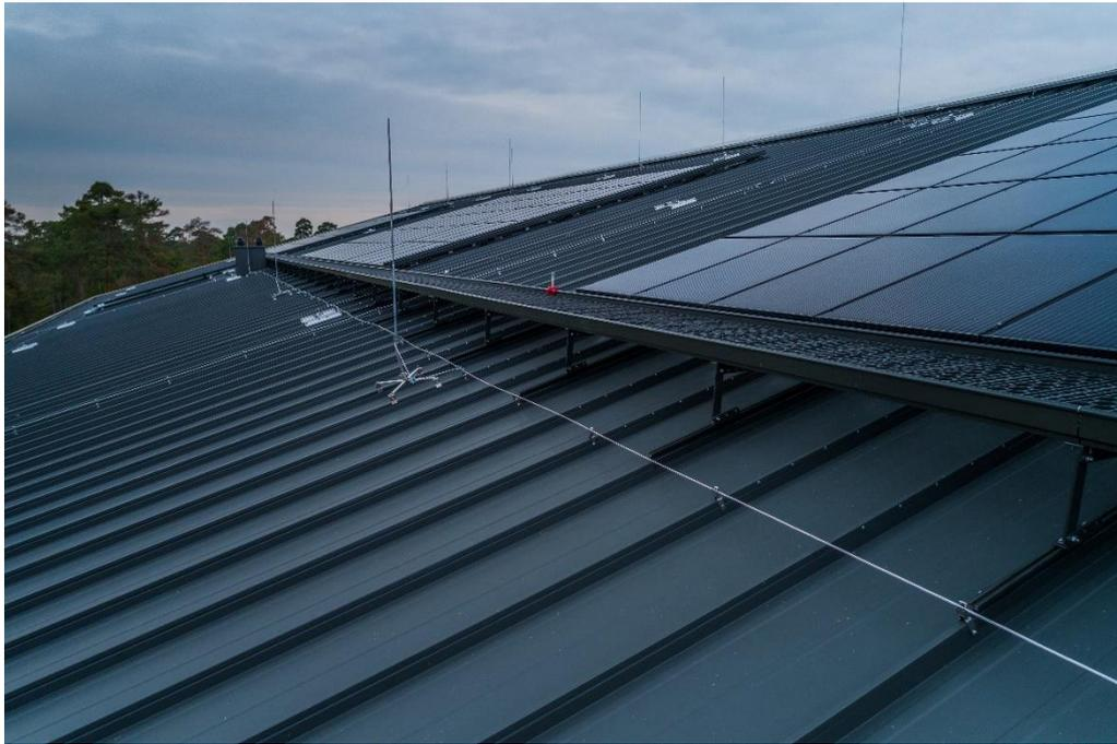
*Bedeckt wurde die Alnatura Arbeitswelt mit einem 3.420 m<sup>2</sup> großen RIB-ROOF Metaldach von Zambelli. Verarbeitet wurde das System RIB-ROOF Speed 500 in Aluminium in der Farbe Umbragrau. Foto: Zambelli RIB-ROOF GmbH und Co. KG*
