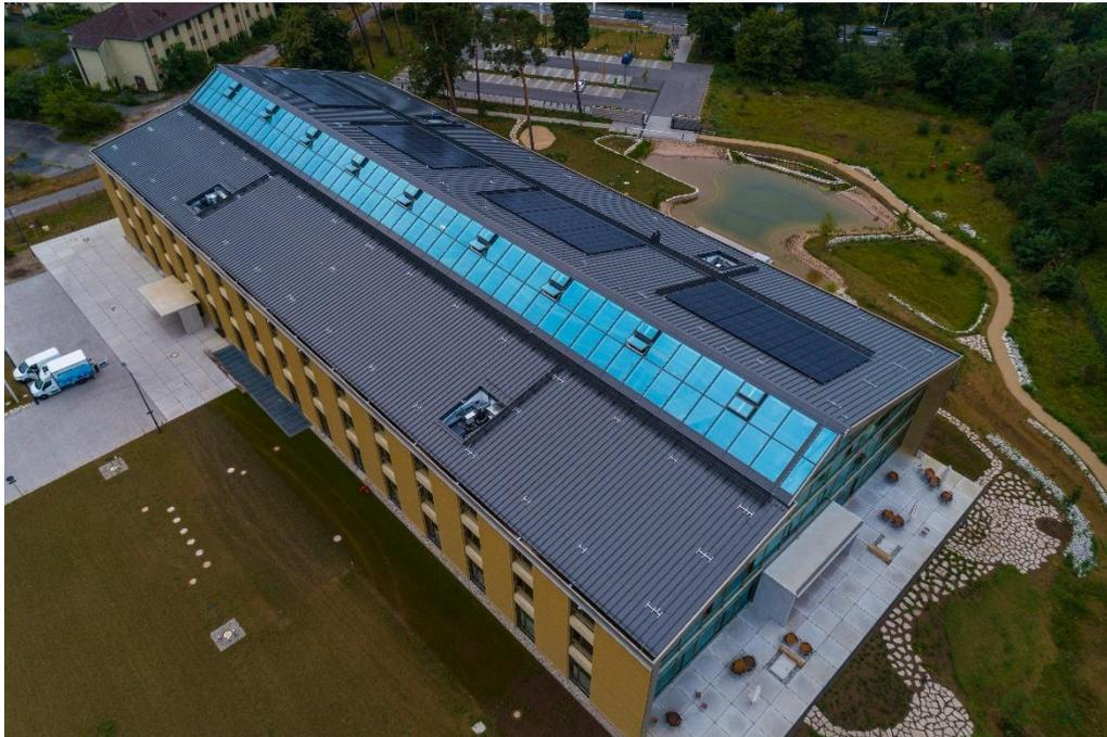
*Das Bürogebäude auf dem Alnatura Campus ist ressourcenschonend unter dem Einsatz natürlicher und wiederverwendbarer Materialien entstanden. So wurde für die Fassade unter anderem Lehm verwendet, ein langlebiges Material mit einer hervorragenden Luftfeuchteregulation und Wärmespeicherfähigkeit. Foto: Zambelli RIB-ROOF GmbH und Co. KG*
