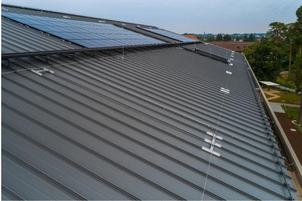
*Neben einer 525 m langen überfahrbaren Seilsicherung und 200 lfm farbbeschichtetem Schneefang, wurden auch teilweise Photovoltaik-Anlagen installiert. Foto: Zambelli RIB-ROOF GmbH und Co. KG*
