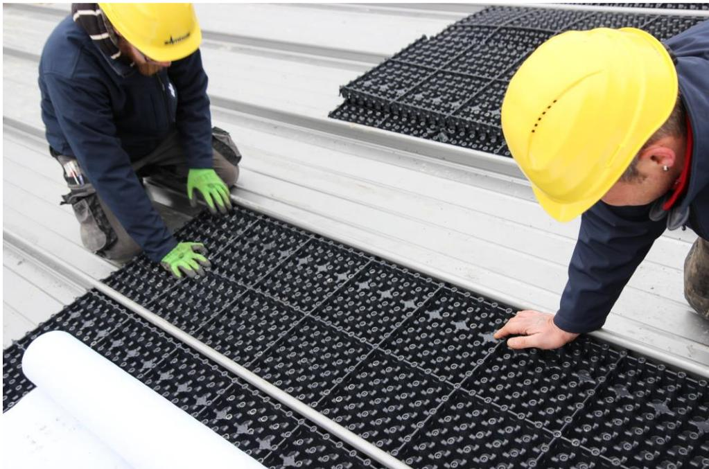
*Das Urbanscape Drainage-System mit Wasserspeicher wird auf die RIB-ROOF Bahn gelegt. Dabei ist darauf zu achten, dass die Ränder unter dem Profilbahnsteg liegen.*
