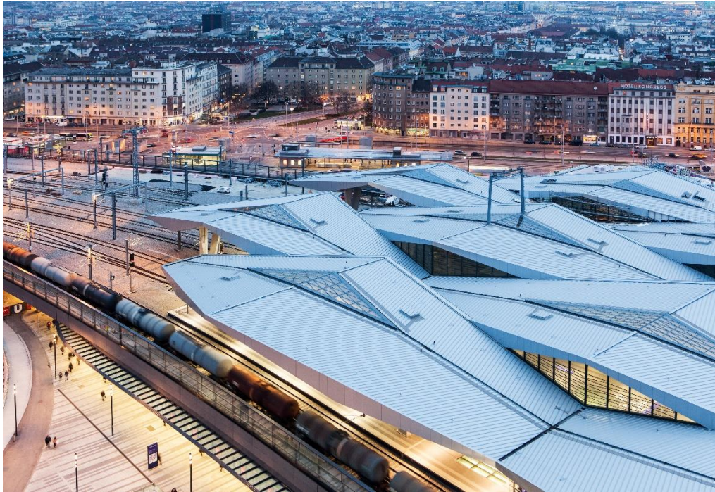
Das Rautendach auf dem neuen Hauptbahnhof Wien verbindet moderne Architektur mit Funktionalität. Die RIB-ROOF Speed 500 Profilbahnen wurden mit Hilfe flacher Clipleisten befestigt. Fotografin: Renée Del Missier
