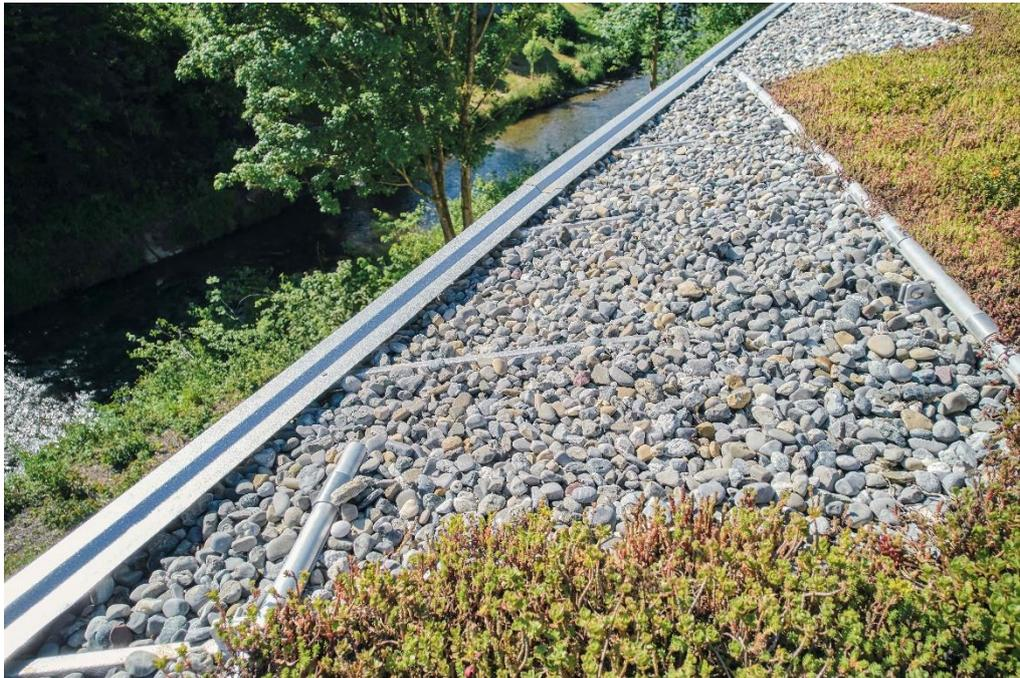
*Das Gründach-Komplettsystem von Zambelli RIB-ROOF und KNAUFINSULATION punktet in Sachen Nachhaltigkeit. Die innovative Wachstumsmatte ist nicht nur sehr leicht, sie kann auch bis zu 60 Liter Wasser pro m<sup>2</sup> speichern.*
