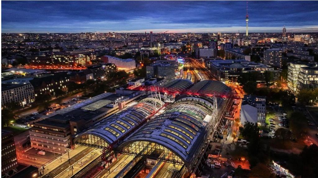
*Der Berliner Ostbahnhof wird bis 2026 umfassend modernisiert. Die über 100 Jahre alten Gleishallen erhielten dabei neue Metalldachsysteme bei laufendem Betrieb. Das RIB-ROOF Speed 500 von Zambelli ersetzt die alte Stehfalzeindeckung: eine logistisch und technisch anspruchsvolle Aufgabe. Foto: DB Engineering & Consulting GmbH/Marius Müller*
