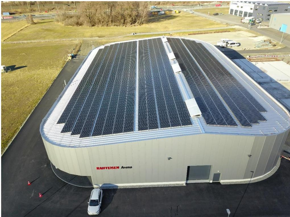
*Insgesamt wurden ca. 2.700 m<sup>2</sup> RIB-ROOF Speed 500 für das Dach verwendet. Als Unterkonstruktion diente eine Tragschale aus Trapezblechen mit einer Wärmedämmung aus trittfesten Dämmplatten. Die einzelnen Profilbahnen wurden mittels Clipmontage, d. h. mit zum System gehörenden 750 mm großen Richtclips, durch die Dämmung in das darunterliegende Trapez durchdringungs- und querstoßfrei befestigt. Foto: Zambelli GmbH & Co. KG*
