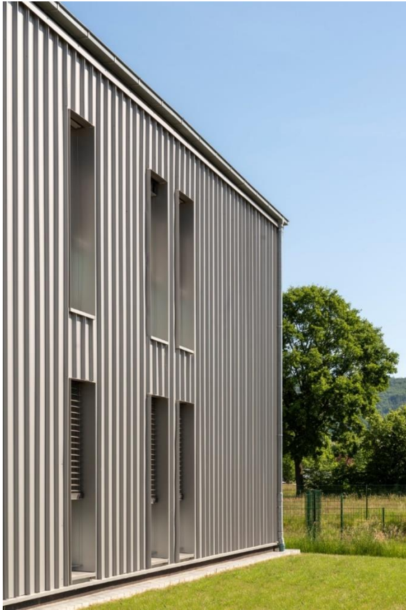
Das eingesetzte RIB-ROOF Metallprofil 465 in der Farbe RAL 9007 „Graualuminium“ wirkt zeitlos und modern.
