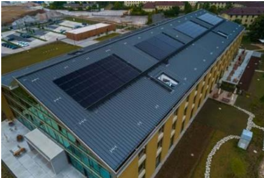
Das Gebäude ist nahezu klimaneutral und leistet damit einen hohen CO 2 -Ausgleich. Die Photovoltaikanlage auf dem Dach deckt einen Großteil der Stromversorgung. Foto: Marc Zeitler
