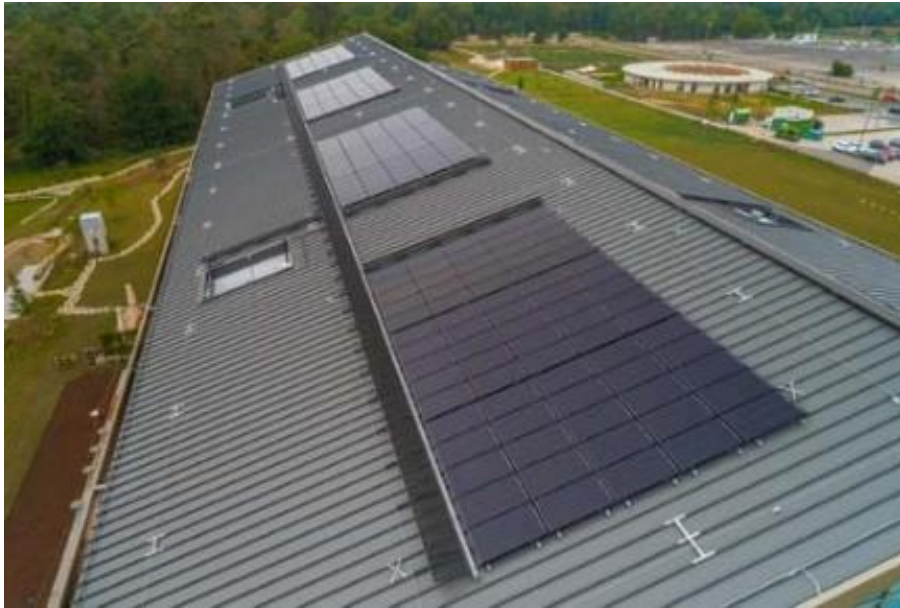
Für die Befestigung der Photovoltaikanlagen kamen die Solar-Lösungen von Zambelli zum Einsatz. Foto: Marc Zeitler
