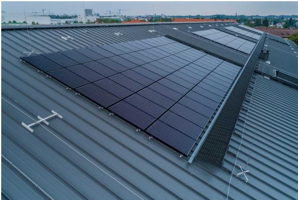
Einfache und zugelassene Befestigung: Die Solar-Lösungen von Zambelli tragen zu einer schnellen und sicheren Montage von Photovoltaikanlagen bei. Foto: Marc Zeitler
