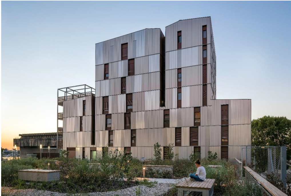
Eines der Messehighlights im Bereich der Gebäudehülle: Die Zambelli Siding-Profile. Mit den Paneelen können ausdrucksstarke Gebäudeansichten realisiert werden. Sie eignen sich in verschiedenen Baubreiten für vorgehängte, hinterlüftete Fassaden als Leichtbausystem. Foto: Zambelli Holding GmbH
